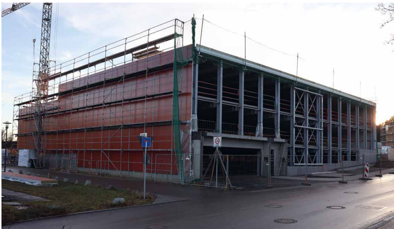
› Blick von der Schulstraße auf die Quartiersgarage und deren Ein- und Ausfahrt
