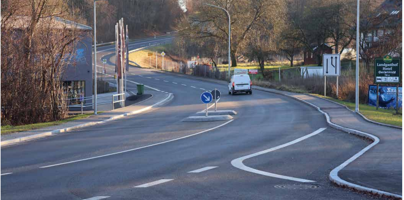
► Die neue Querungshilfe der B 15 in Grammelkam
