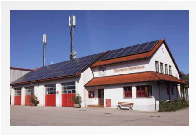
› „Gerätehaus Feuerwehr Niederkam“
