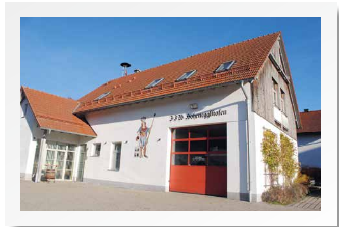
› „Gerätehaus Feuerwehr Hoheneckhofen“
