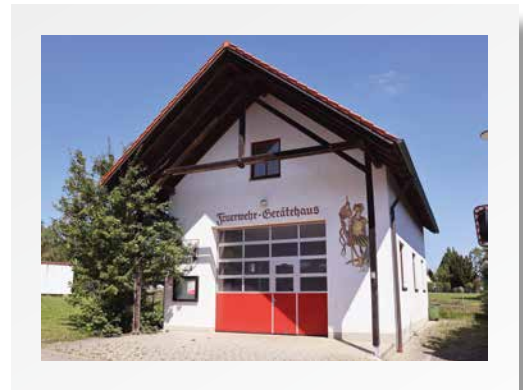
› „Gerätehaus Feuerwehr Windten“
