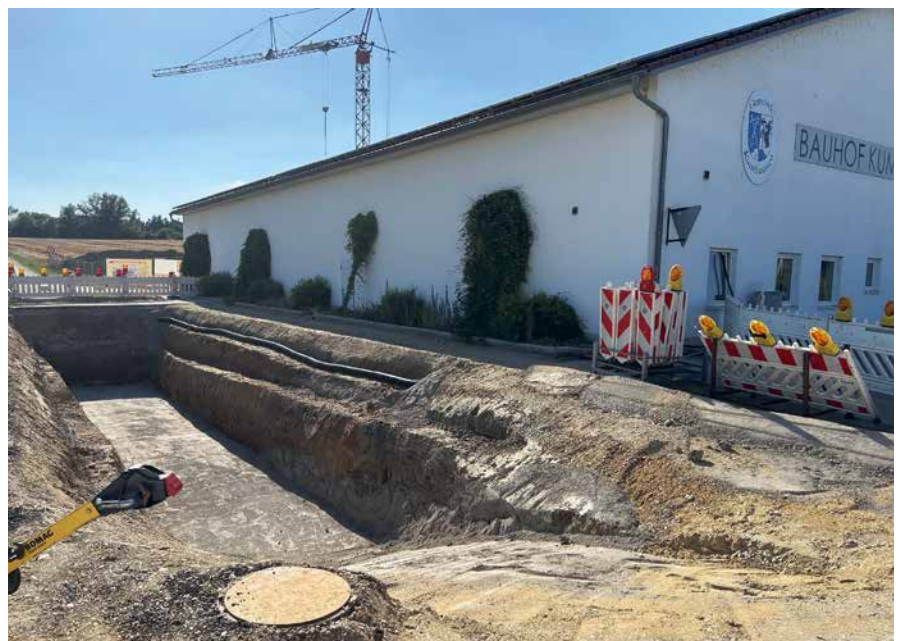
▶ Baugrube für den Stauraumkanal
