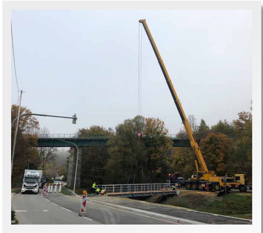
› Der Steg wurde als ein Stück eingehoben
