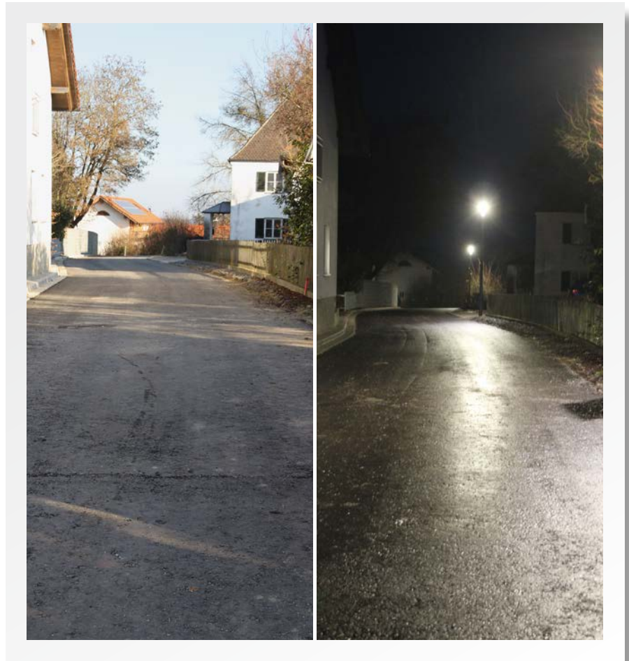
▸ Badstauden mit Asphalttragschicht und bei Nacht
