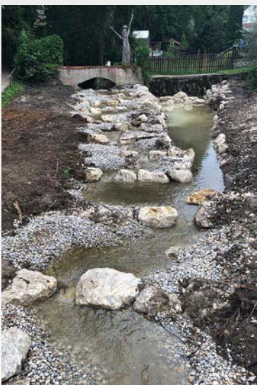
▸ an der Roßbachstraße bei Normalwasser
