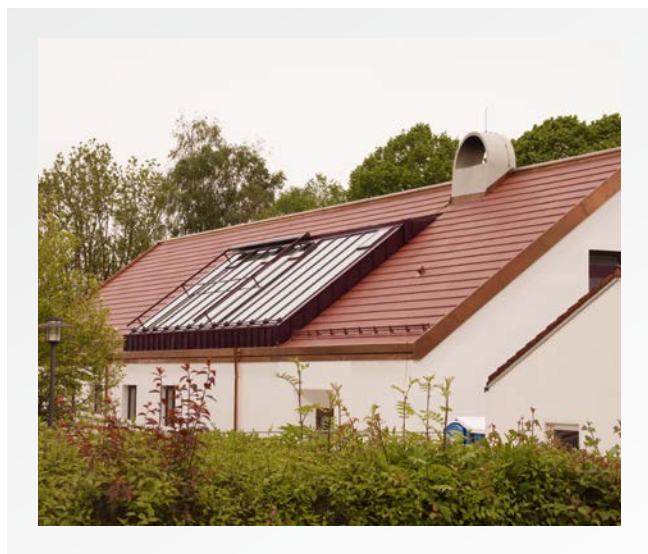
› Eingangsseite mit großzügig aufgeglaster Dachfläche
